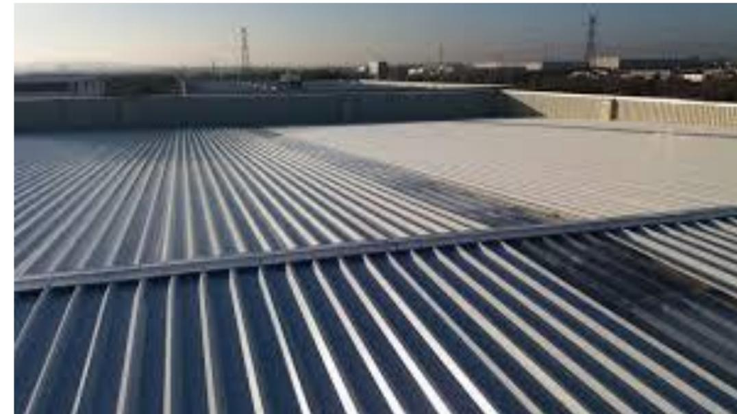
El sistema esta formado por el acoplamiento in-situ de una membrana a base de Poliurea de aplicación en frío, a un panel termo aislante de poliestireno expandido (EPS) dibujado según la tipología de la cubierta. **CoverTerm-GRECA** es un sistema cubriente aislante e impermeabilizante apto para la renovación de cubiertas industriales de paneles de chapa grecada tipo chapa Pegaso.
